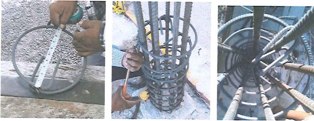
NUEVO HABILITADO Y AMARRE DE LOS ANILLOS EN LAS COLUMNAS CON 8 VARILLAS DE  $\frac{3}{4}$ " Y ESTRIBOS DE  $\frac{3}{8}$ " @ 8 CM EN 70 CM CON EL GANCHO DE 12 CM. DE ACUERDO A PROYECTO
