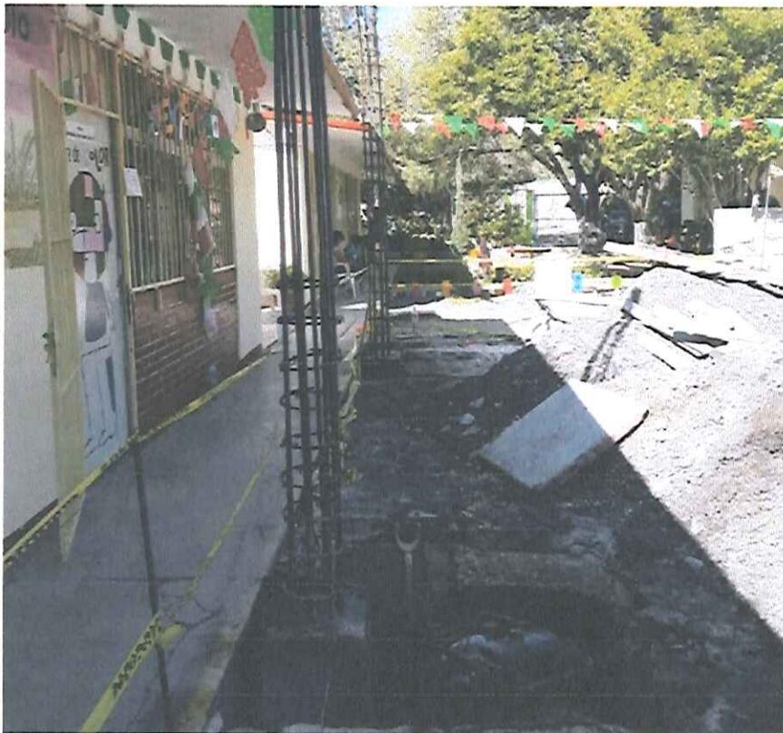
**PRESENTO A CONTINUACION EXCAVACION PLANTILLA Y ARMADO DE ZAPATAS DEL EJE 1 CON PROFUNDIDAD DE EXCAVACION DE 1.90 MTS (PTO 3.00)**
