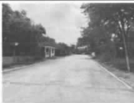
PAVIMENTACION EN CONCRETO HIDRAHULICO EN CALLE YUCATAN
