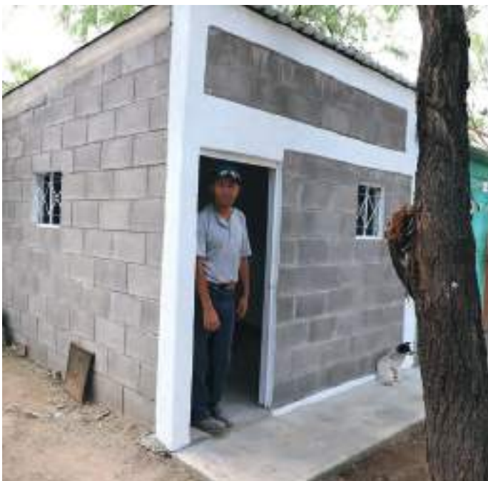
Para contar con una vivienda digna, se apoyó a familias con piso firme, muro divisorio, techos de lámina y con cisterna de agua
