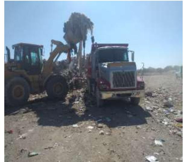
DURANTE TODO EL MES, CADA DIA SE REALIZAN LOS TRABAJOS DE ABUNDAMIENTO DE RESIDUOS; ESTOS TRABAJOS SE REALIZAN DIARIAMENTE. DICHS TRABAJOS LOS REALIZAN LOS OPERADORES DE MAQUINARIA Y CONSISTEN EN ABUNDAR LOS RESIDUOS SOLIDOS CON LA MAQUINA RETROEXCAVADORA Y/O CARGADOR; UNA VEZ QUE SE TIENEN ABUNDADOS LOS DESECHO SE CARGAN EN LOS CAMIONES DE
