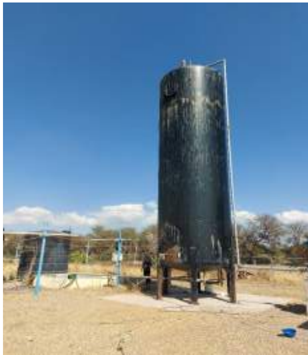
Fotografía 5 Reactor anaerobio
