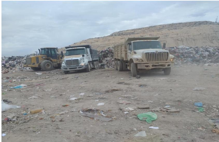
DURANTE TODO EL MES, CADA DIA SE REALIZAN LOS TRABAJOS DE ABUNDAMIENTO DE RESIDUOS; ESTOS TRABAJOS SE REALIZAN DIARIAMENTE. DICHS TRABAJOS LOS REALIZAN LOS OPERADORES DE MAQUINARIA Y CONSISTEN EN ABUNDAR LOS RESIDUOS SOLIDOS CON LA MAQUINA RETROEXCAVADORA Y/O CARGADOR; UNA VEZ QUE SE TIENEN ABUNDADOS LOS DESECHO SE CARGAN EN LOS CAMIONES DE
