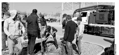
Trabajadores municipales realizaron trabajos de mejora.
