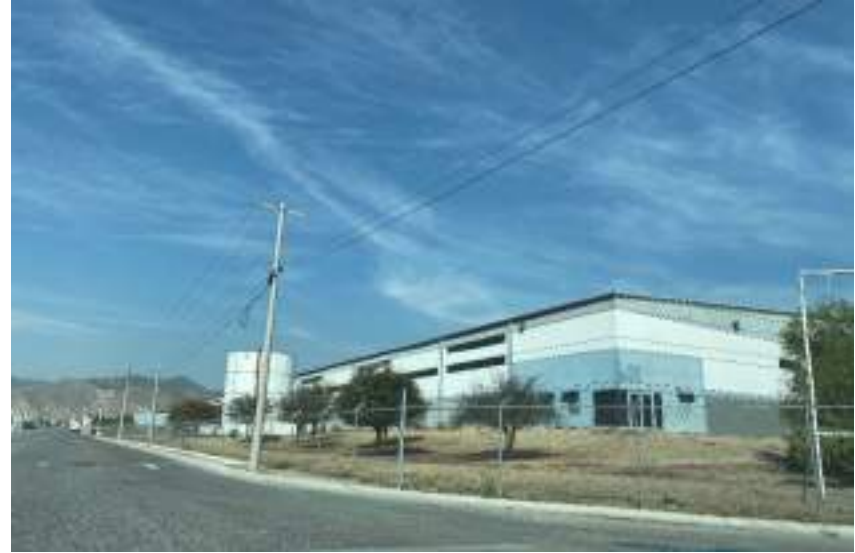
Vista lateral de la planta NYX
