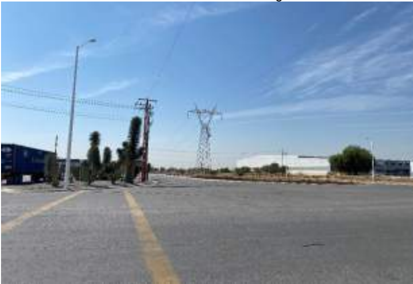
Red de energía eléctrica en parque Logistik
