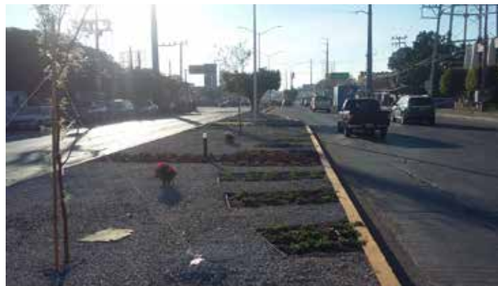
2. REHABILITACION CAMELLON BOULEVARD CARLOS JONGUITUD BARRIOS DE PORFIRIO DIAZ AL BLVD FERROCARRILERO
