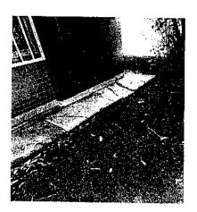
SEPARACION Y HUNDIMIENTO DE MUROS Y BANQUETAS POR ASENTAMIENTO Y MODIFICACION ESTRUCTURAL DEL SUELO
