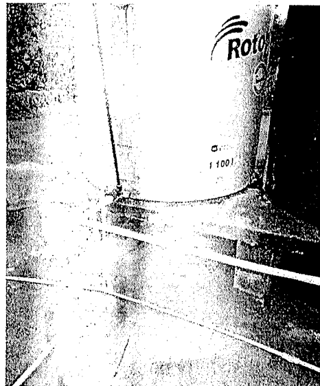
BAJADAS DE AGUA PLUVIAL EN ESTRUCTURA CON DESCARGA EN LOSA, FUGA PERMANENTE EN TINACOS
