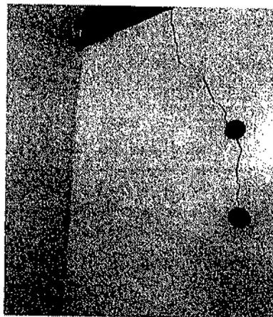
DESPRENDIMIENTO DE MATERIALES DE RECUBRIMIENTO Y GRIETAS EN DIAGONAL
