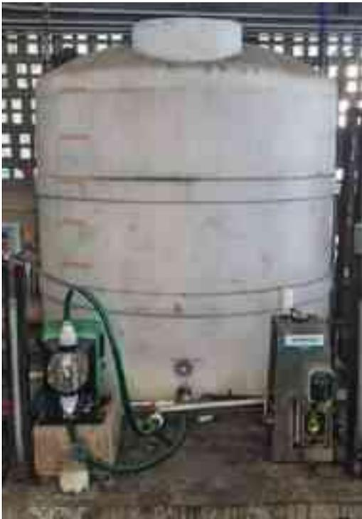
Ilustración 6. Tanque de 3000L habilitado para polímero coagulante.
