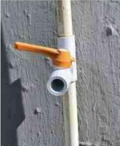
Ilustración 4. Llave para aforo de polímero coagulante en caja de mezcla
