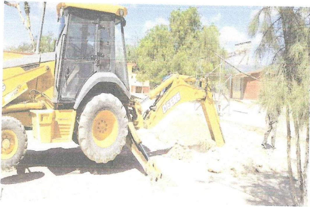
EXCAVACION DE SONDEO
