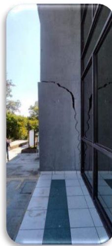
Imágenes 7, 8 y 9: Daños estructurales del edificio "G".
