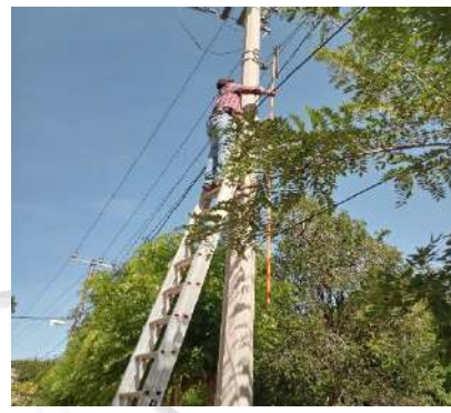
ABASTECIMIENTO DE AGUA AL INPI Y COLOCANDO PASTILLAS TÉRMICAS AL ARRANCADOR DE LA BOMBA DEL TEMPESHKITE.
