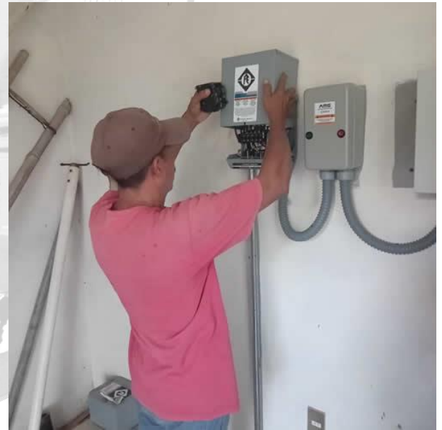
CHECANDO EL ARRANCADOR DE LA BOMBA PARA SU REPARACIÓN
