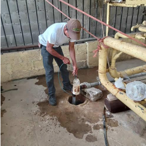
REALIZANDO CLORACIÓN DE AGUA
