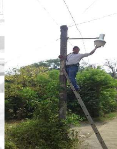
REVISIÓN Y COLOCACIÓN DE FOCOS NUEVOS
