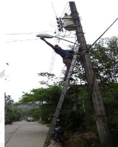
REVISIÓN Y COLOCACIÓN DE FOCOS NUEVOS
