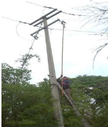
SUBIDA DE CUCHILLAS EN SOLEDAD
