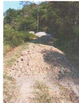
LEVANTAMIENTO DE OBRAS
