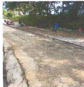
SUPERVISION DE OBRAS
