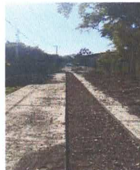
SUPERVISION DE OBRAS
