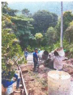
SUPERVISION DE OBRAS
