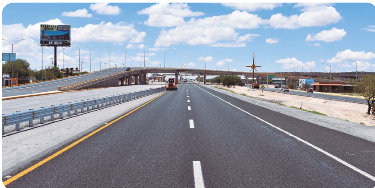
APP Conservación carretera San Luis Potosí – Querétaro (Tramo: de Entronque Libramiento Oriente de S.L.P. – Entronque carretera a Villa de Reyes).
