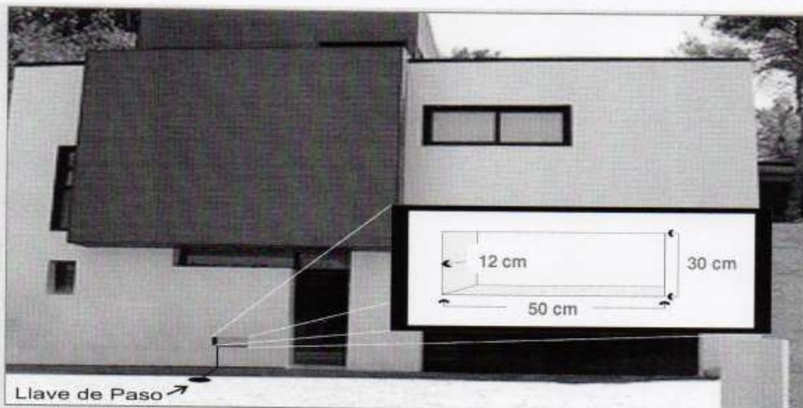
**Nota** El cuadro para la instalación del medidor debe estar a 60 cm. Del suelo
